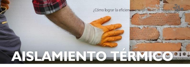
La envolvente de una casa está formada por todos los elementos de construcción que están en contacto con el exterior. Estos son: pisos, techos, muros y carpinterías (puertas y ventanas). Aislar térmicamente la envolvente de una casa es uno de los puntos más importantes para reducir el consumo de energía por calefacción y refrigeración. También es importante aislar las instalaciones (cañerías y tanques de acumulación).
